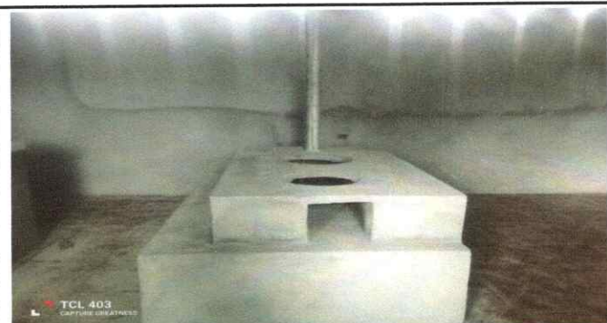
Foto 5: Finalización de poyeton
