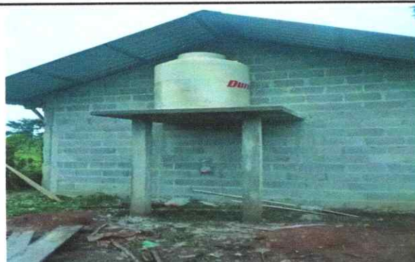
Foto 4: Finalizacion de Colocacion de Tinaco
