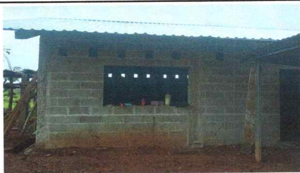
Foto1: Finalización de Colocación De Techo
