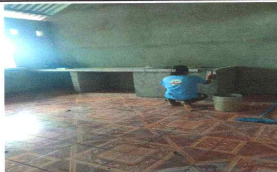
Foto 6: Finalización de Colocación de Pila
