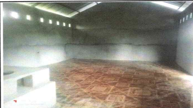
Foto 2: Finalización de Colocacion de piso
